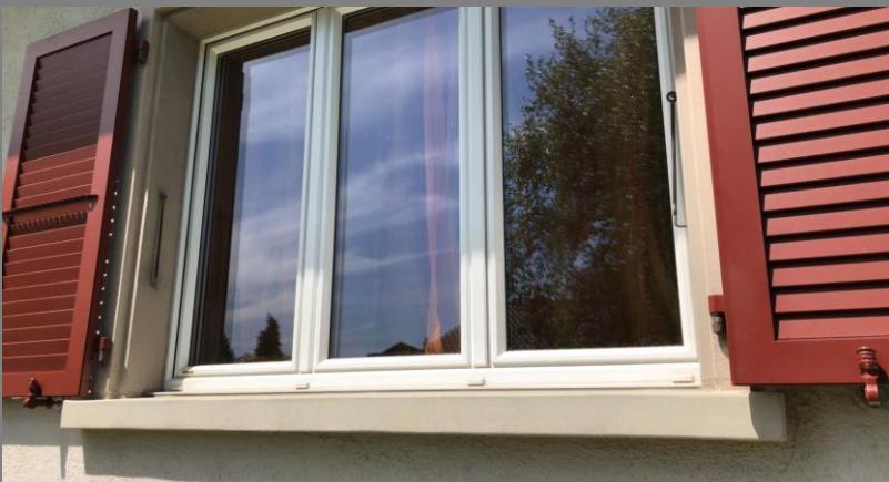
Zustand Fenster aussen
